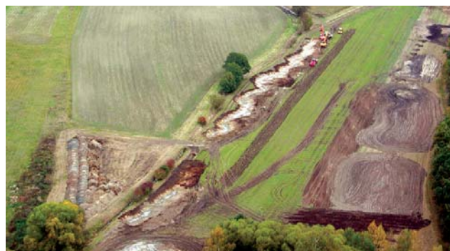
Luftbildaufnahme während der Bauphase
