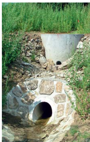
Absperrbauwerk für Rückhaltung
