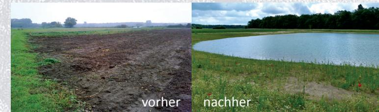
Das Wachstum der Röhrichtbestände wird durch Geländemodellierung gelenkt: Der Flachwasserzone mit bis zu 1,0 m Wassertiefe folgt ein steiler Abfall mit einer Neigung von 1 : 2 bis in eine Wassertiefe von 2 m – 2,5 m, wodurch das Schilfwachstum gebremst wird.
